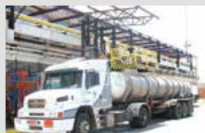
Mástil Elevador para acceder a la boca de inspección de camiones cisterna.
