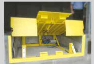
Pestaña tripartita para acceso de vehículo de menor porte.
