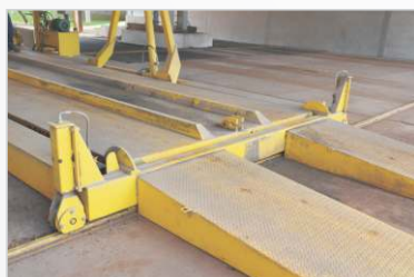
Rampa cerrada en la salida de la plataforma.
