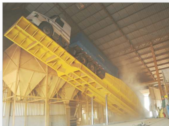
Construcción mecánica con perfil "I".
