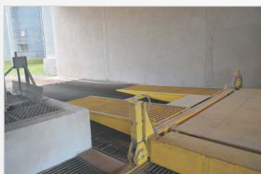
Rampa metálica enrejada: para instalarla en la entrada de la plataforma.
